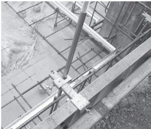
主筋の内側にせん断補強金とアンカーボルト
