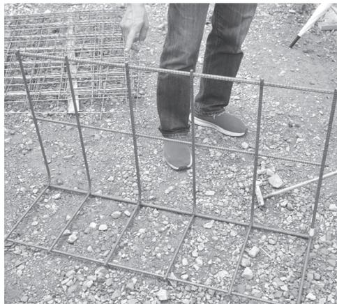
T字ではなくL字の鉄筋を用いている
