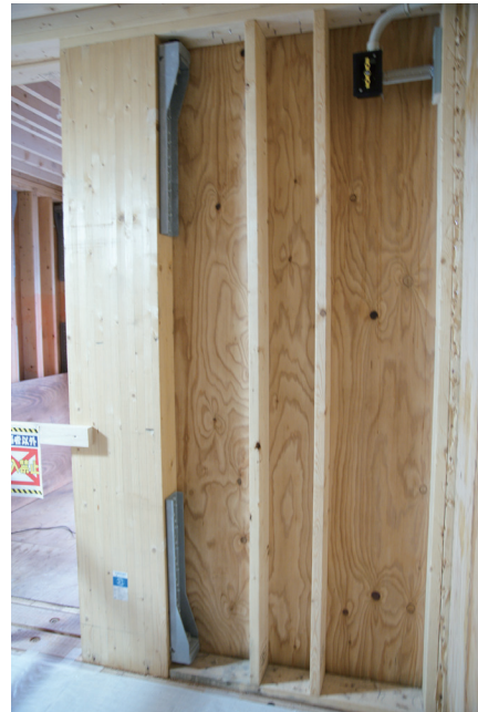
大型のホールダウン金物を設置
