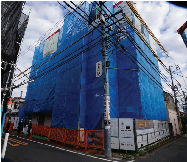
JR 総武線信濃町駅徒歩6分の現場
