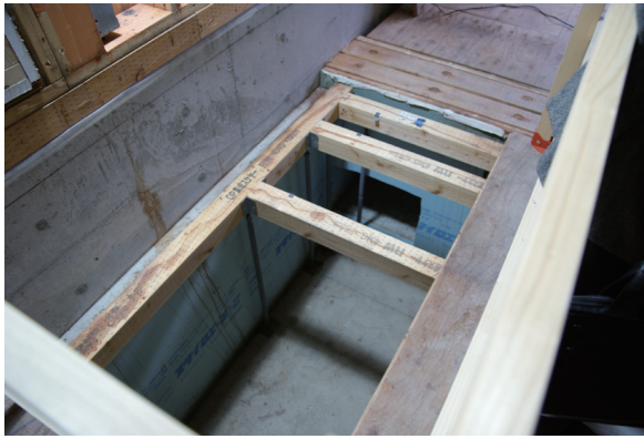
GL から約 1.5m 下を基礎底盤に
