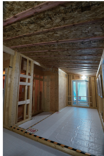
枠組壁工法で建築中
