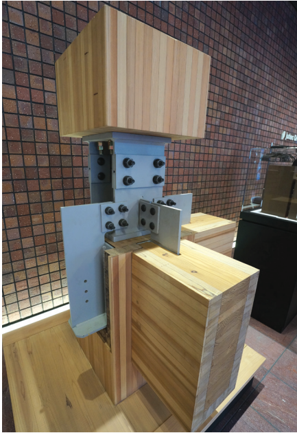
柱の接合は鉄骨を用いた高力ボルト接合
