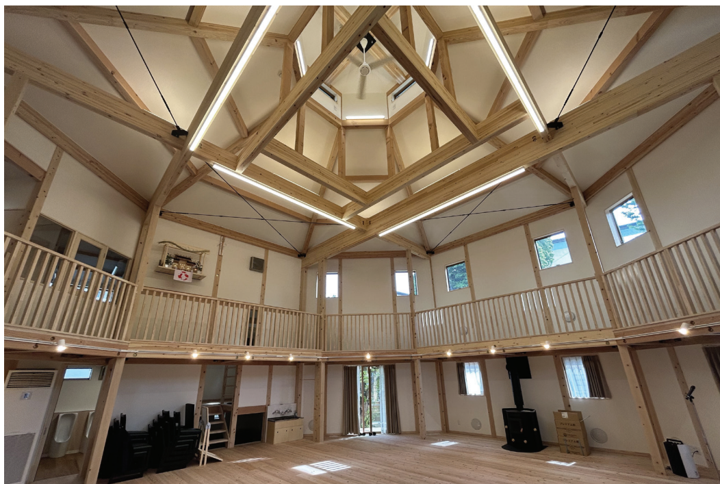
保育スペース天井は、1辺が2間半の正八角形、最大スパン11m半
