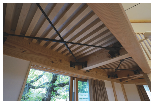
ブレースを配置し水平構面を確保
