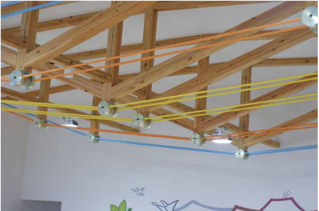
ATA ハイブリッドトラス 1時間準耐火仕様として金物のまわりに2mmの耐火塗装をして色をつけている
