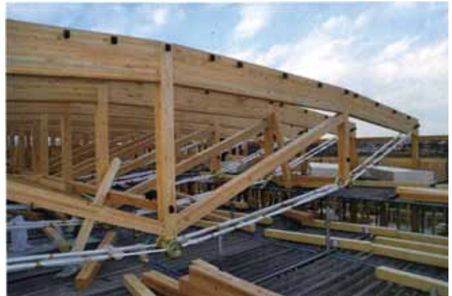
クレーンを使ったATAハイブリッドトラスの建て方工事
