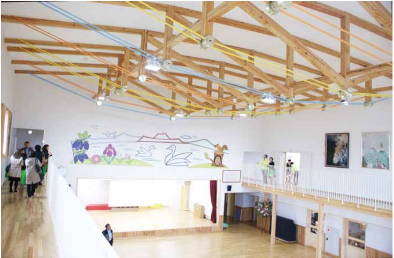
270㎡のホールは、壁から壁までの長さ15mが、柱のない構造となっている
