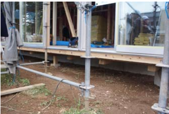
基礎はコンクリートを減らし高炉セメントの布基礎
