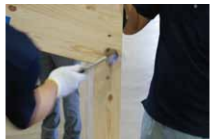
⑥ ドリフトピンで登り梁と柱を固定
