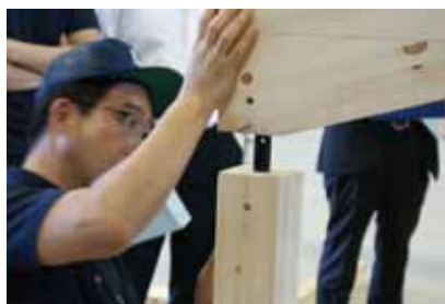
⑤ 柱のほぞパイプに落とし込む
