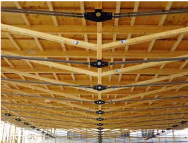
広島県福山市のスーパーマーケットで採用された ATAハイブリッドトラス
