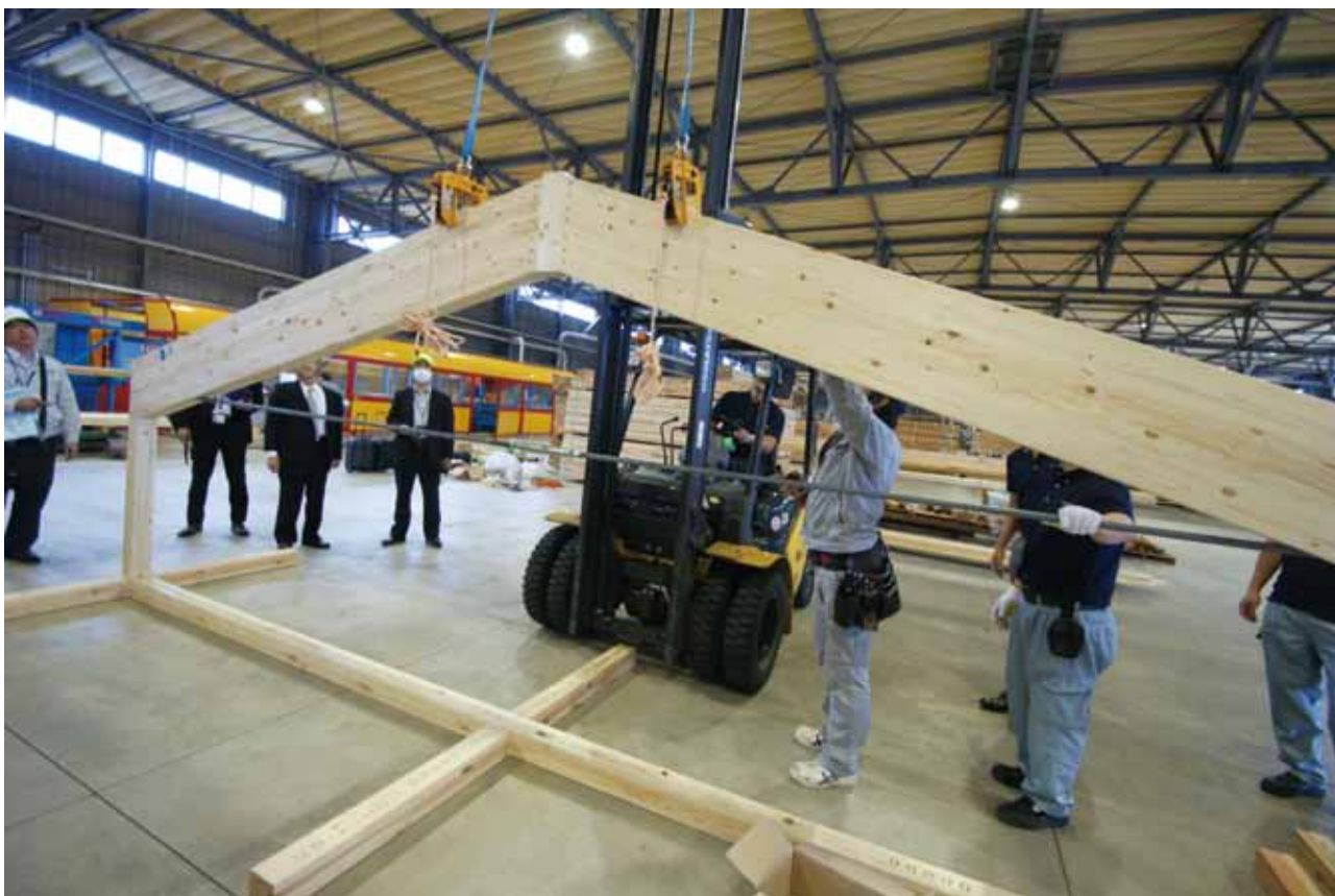
大三商行の東金プレカット工場（千葉県）にて6mの山型トラスの組立実演をおこなった。
