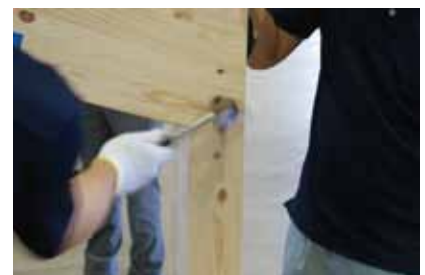
⑥ ドリフトピンで登り梁と柱を固定
