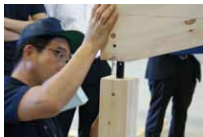
⑤ 柱のほぞパイプに落とし込む
