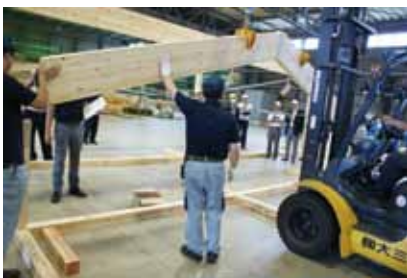
④ ハイブリッドトラスを持ち上げる
