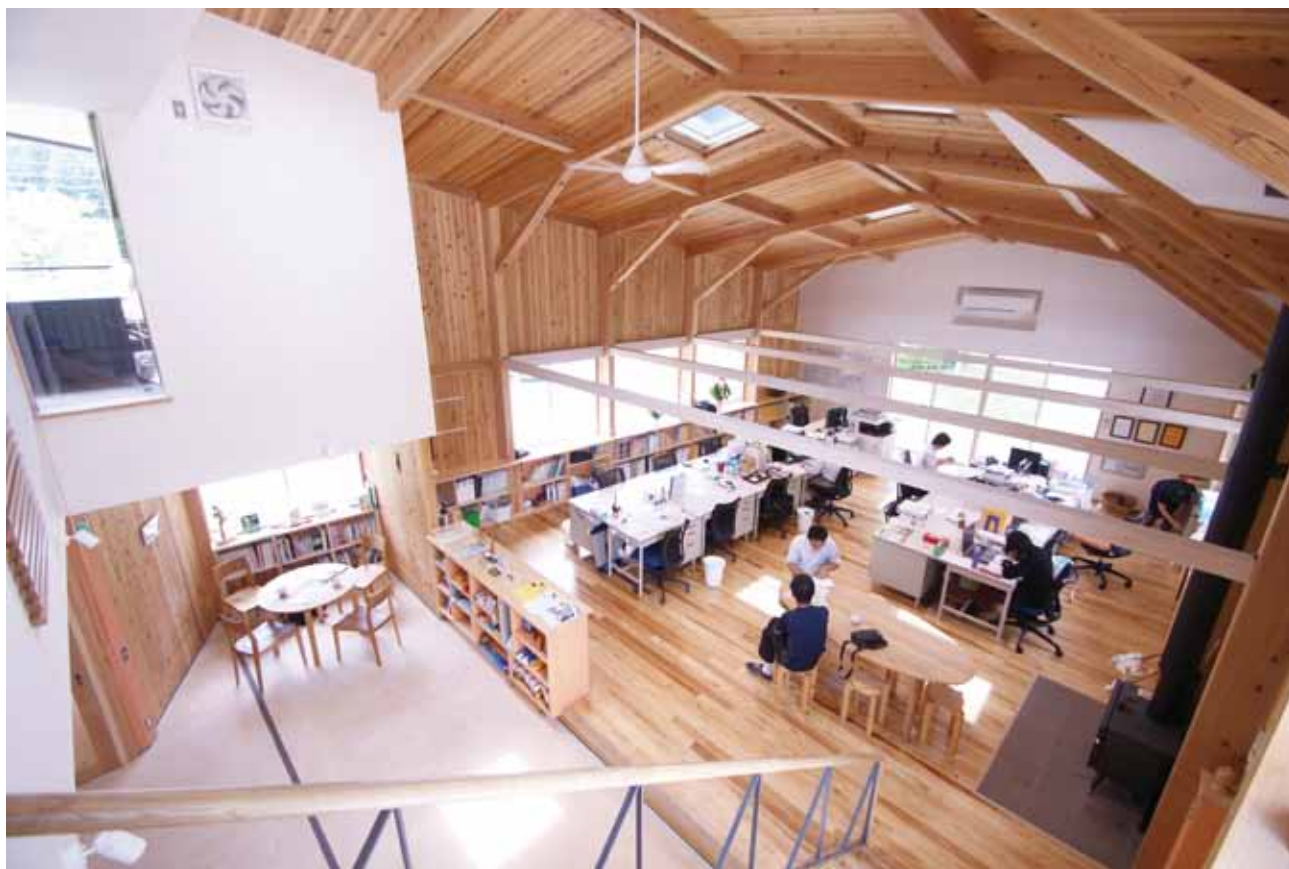
一階事務室スペースを見下ろす 壁や屋根に合板を全く使用しておらず、断熱材をほとんど使用していない
