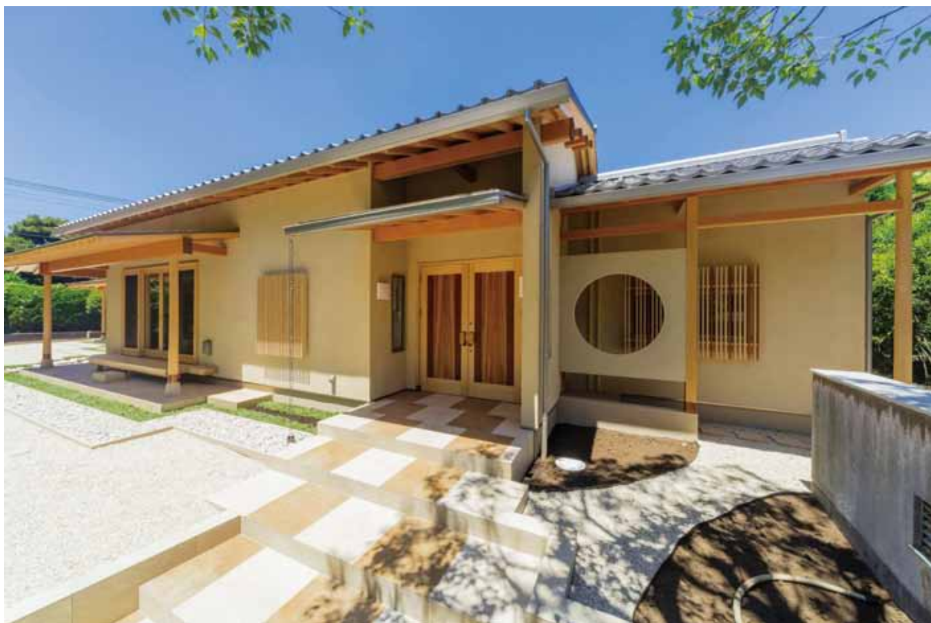
正面玄関 袖壁円窓越しに力竹・晒燻竹の連格子が見える
