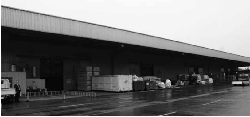
パネル工場（建屋面積約 1,000 坪）
