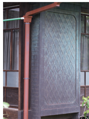
昭和4年に建てられた旧宅。木製建具と青銅製の戸袋に注目。8年前に増築し木製サッシを採用
