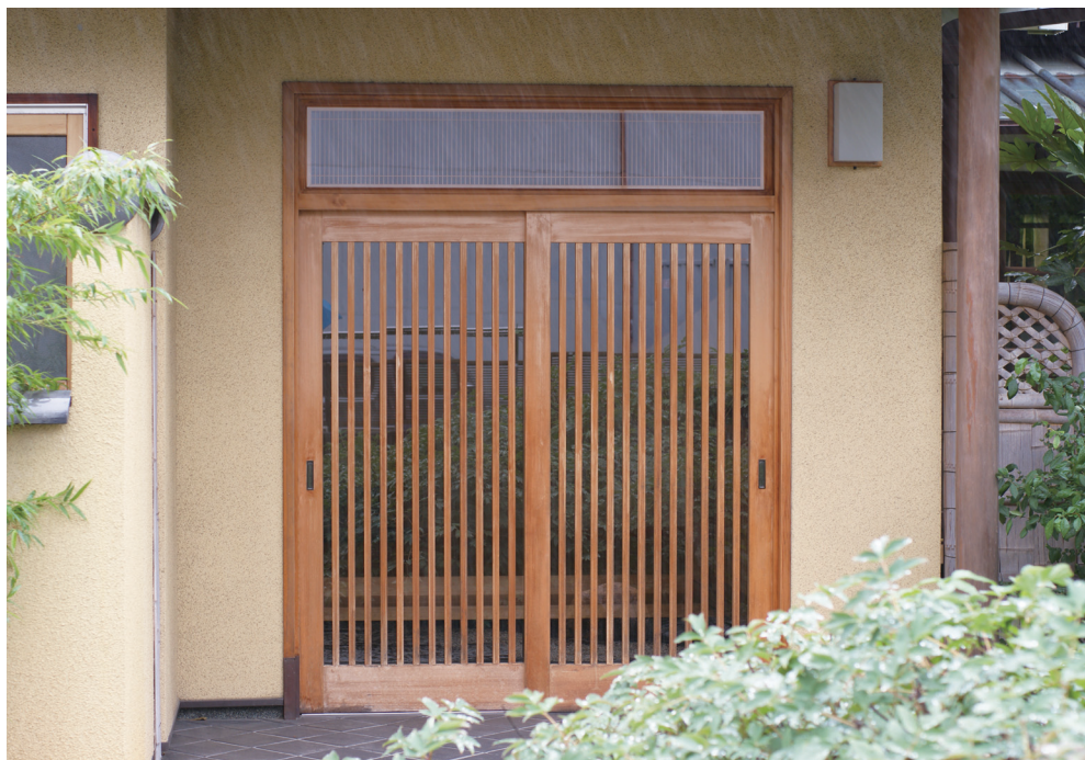
アルミ枠を使って木製サッシを設置
