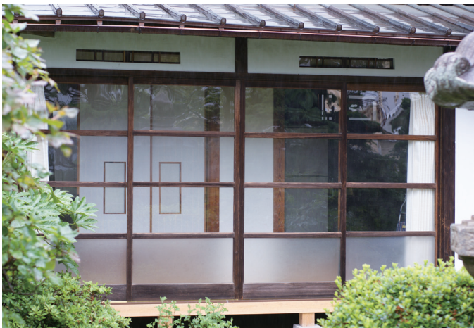
昭和4年に建てられた旧宅。木製建具と青銅製の戸袋に注目。8年前に増築し木製サッシを採用
