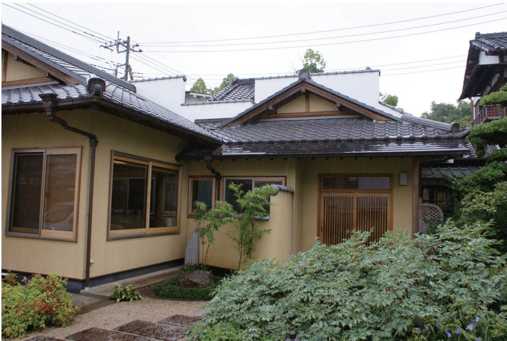
昭和4年に建てられた旧宅。木製建具と青銅製の戸袋に注目。8年前に増築し木製サッシを採用
