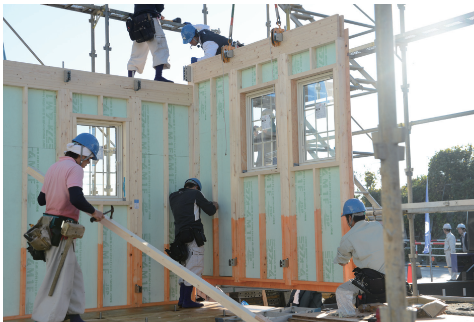
(写真1) クレーンで吊ったパネルをほぞパイプに落とし込んで取付けるだけ
