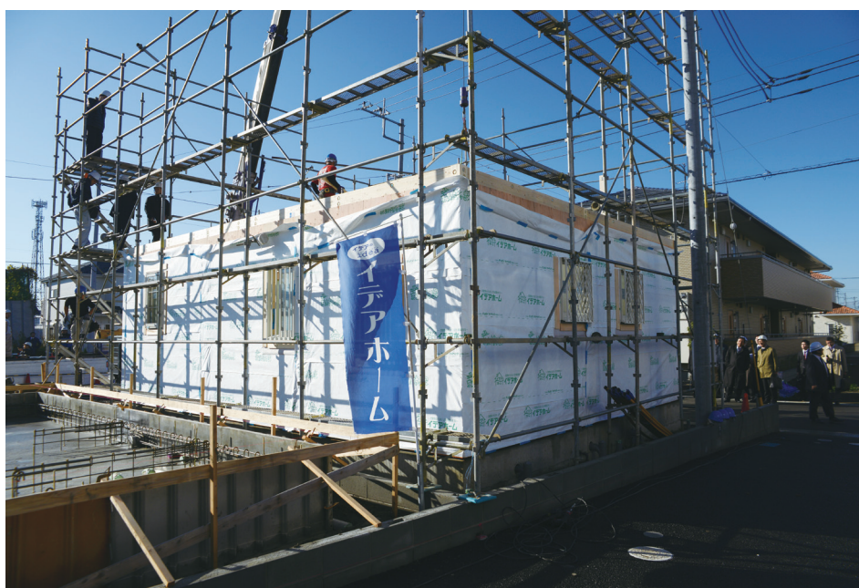
(写真2) 1階の外壁パネルは、わずか30分で終了した
