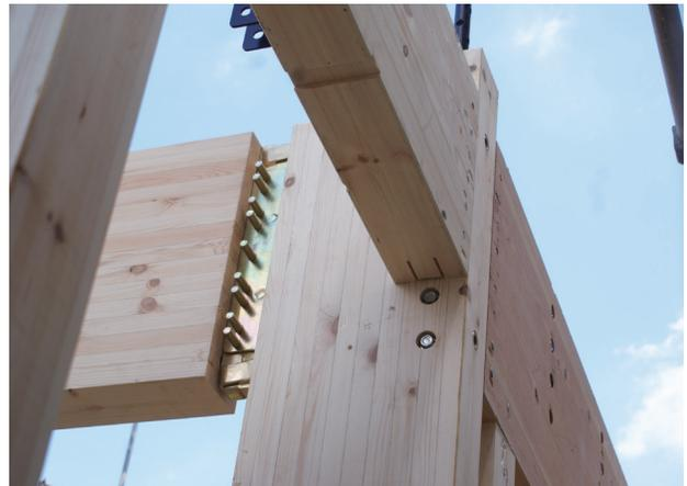
(写真2) 片側ラーメン右側のラーメンフレーム専用金物
