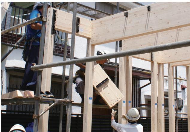
(写真3) 片側ラーメンの左側は105角柱でHSS金物接合
