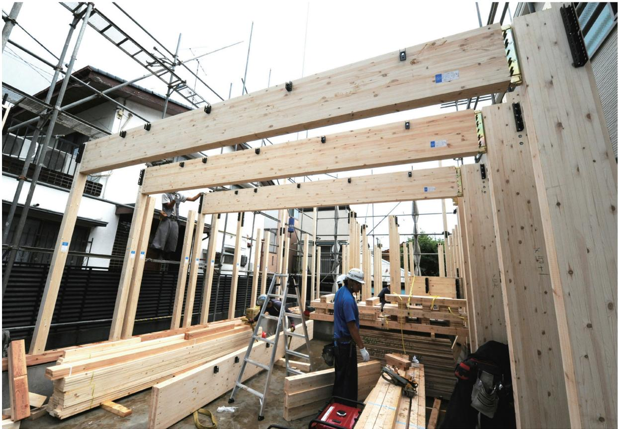
(写真1) 大田区の建て方工事現場 片側ラーメンが入っている
