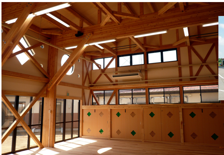
上、左の写真は「スマイルはじめ保育園」（新潟市） 用途：保育園 設計者：アマキ設計 延べ床面積：1074.41㎡ 接合金物：テックワン P 3 金物 + 設計金物
