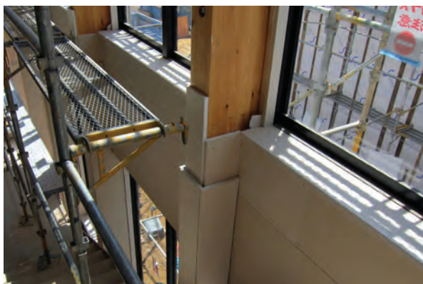
石膏ボード2重貼りの耐火被覆（耐火構造建築）
