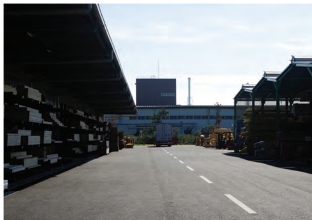
新工場のストックヤード奥に見えるのが旧工場
