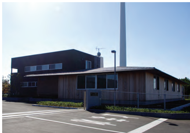
工場に隣接するオフィス棟
