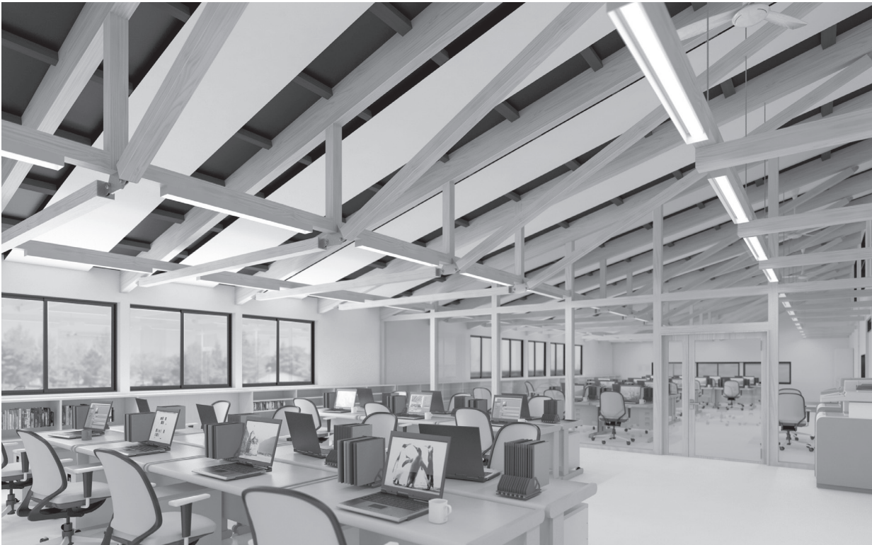
P3プラスを用いたトラスにより9.1mのスパンを実現
