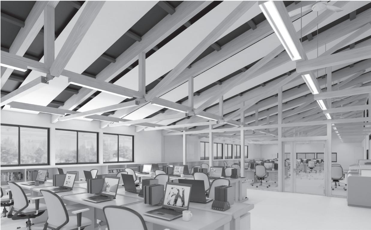
P3プラスを用いたトラスにより9.1mのスパンを実現
